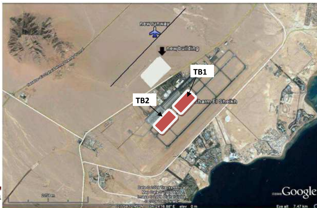
Graphique 1 Vue satellite récente du site de l'aéroport de Sharm el-Sheikh et de l'emplacement du nouveau terminal et de la nouvelle piste dont l'exploitation devrait commencer à partir de 2015
