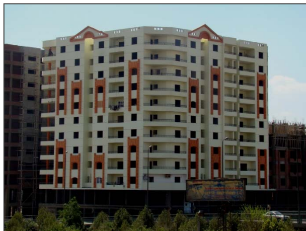
Photo 5 : nouveaux appartements en construction pour 20 employés de CORC, mai 2008.
