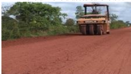
Piste en cours de réalisation
