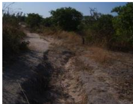
Ravinement sur la piste de Djilong
