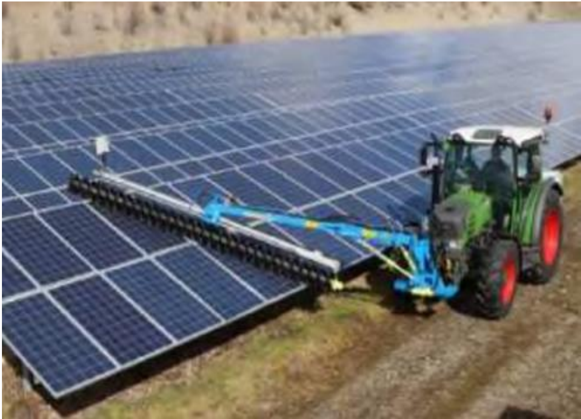
Photo 1: Exemple de Nettoyage semi-automatisé des modules ( étude de faisabilité centrale solaire, 2019 )
